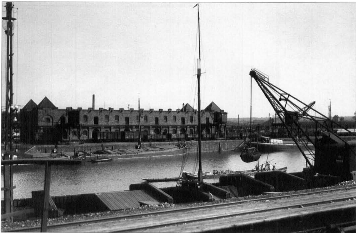
Die Werfthalle I war 1901 fertiggestellt.
