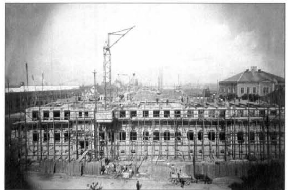
Die Hardtschule, heute Vogesenschule, während des Baus 1908/09.
