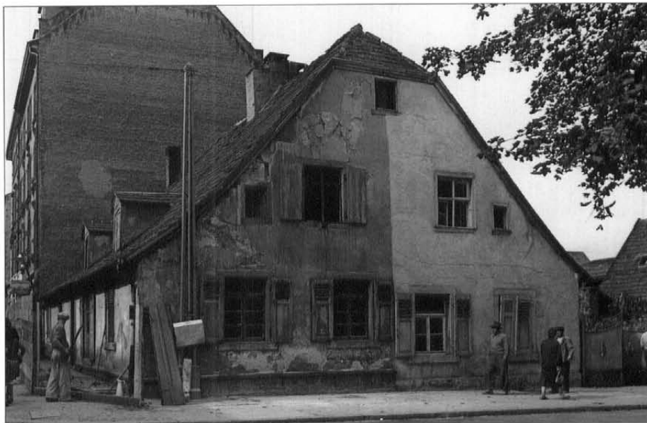
Abbruch eines der ältesten Mühl- burger Häuser im Zusammenhang mit baulichen und verkehrs- technischen Veränderungen zwischen Enten- fang und Lamey- platz. Foto: Horst Schlesiger vom 22. September 1954.
