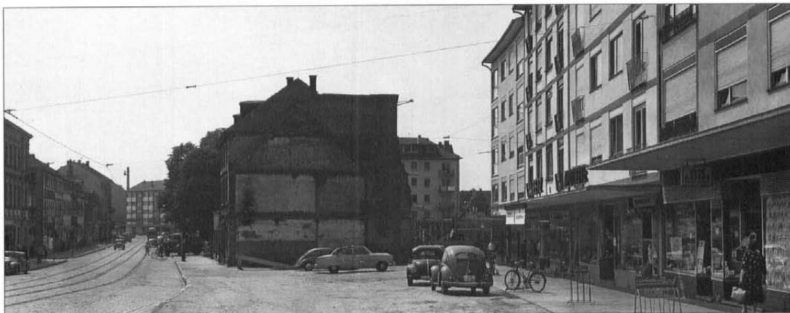
Zustand der Rheinstraße um 1955 mit teilweise bereits zurück versetzter Bauflicht.
