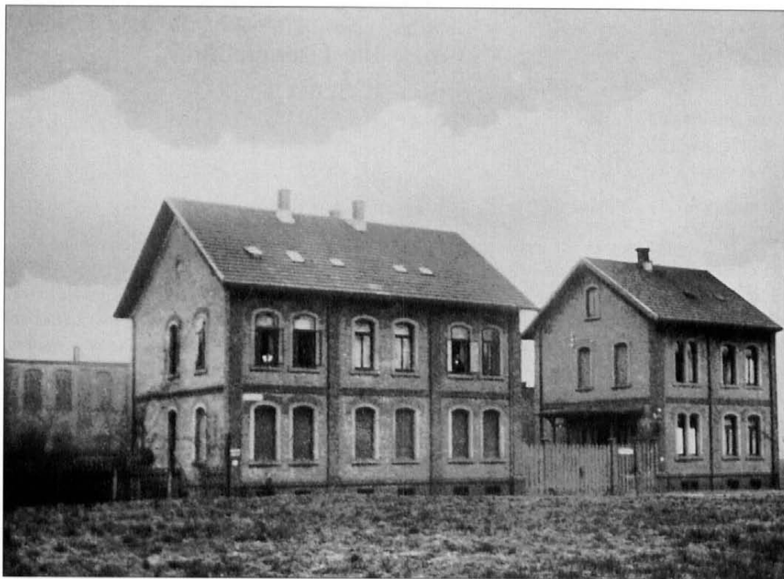
Büro- und Pförtnerhaus um 1895.
