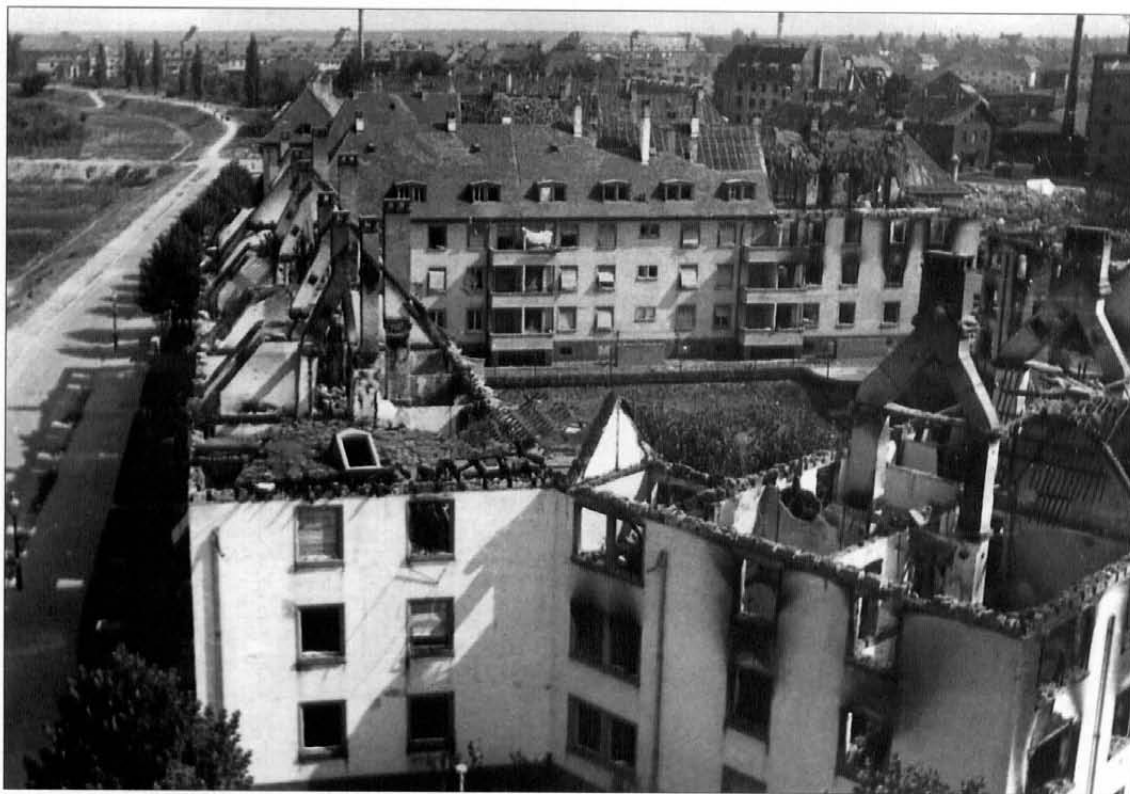
Zerstörte Häuser in der Sonnenstraße. Die Nordsternsiedlung war einer der Schwerpunkte des Angriffes im August 1941.
