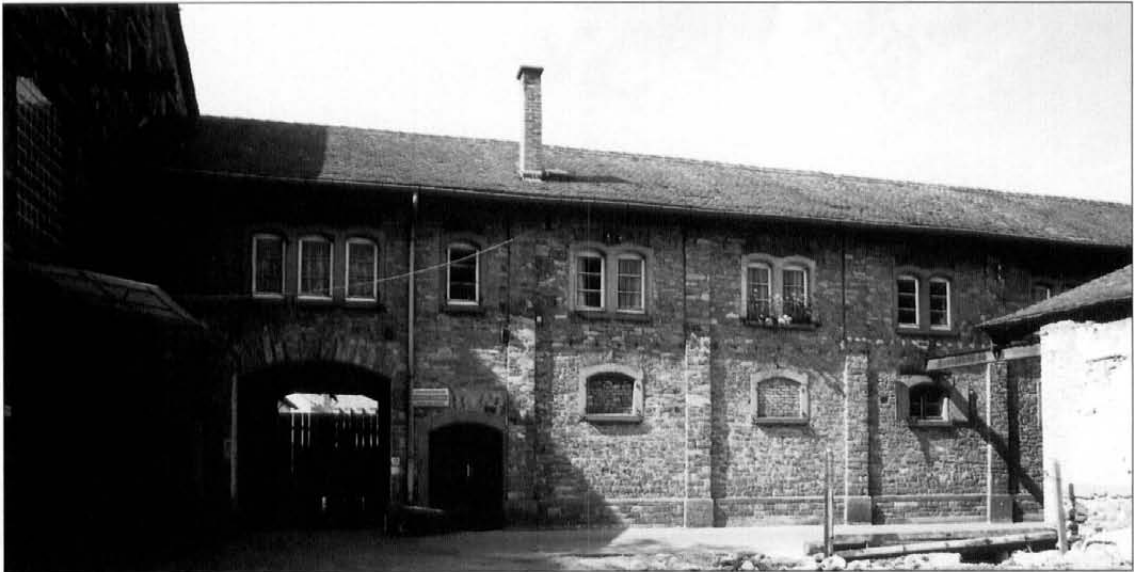
Ehemaliger Bier- und Eiskeller, Nordfassade, Westteil, Foto 1986.
