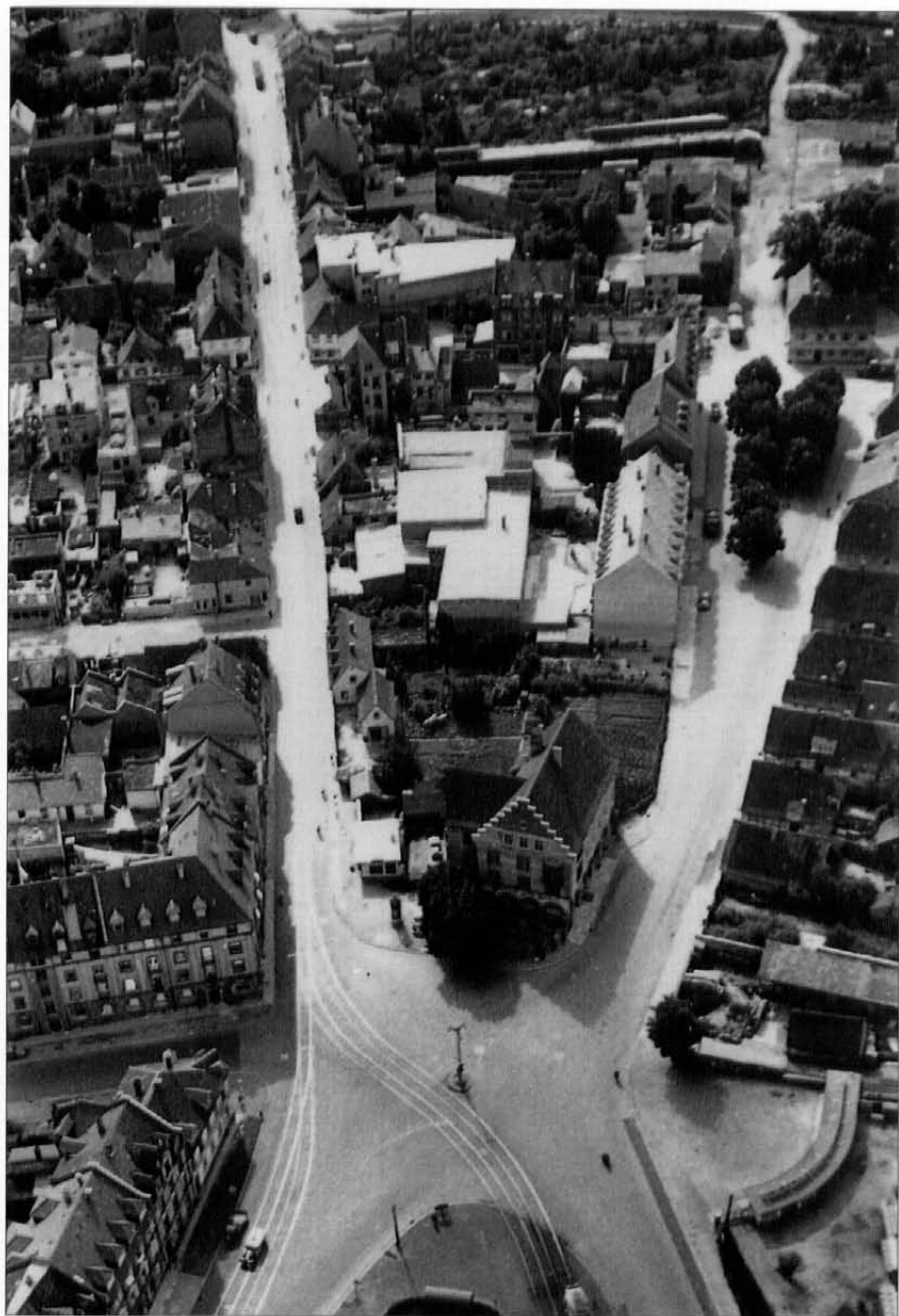
Hardtstraße und Lameystraße vor der Neuordnung.
