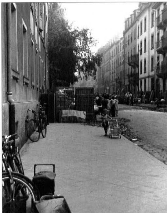
Die Bachstraße während des Krieges. Die Häuser Nr. 13, 15 und 17 wurden schon bei Luftangriffen im August 1941 durch Bombeneinschläge in den Hintergärten der Händelstraße stark beschädigt und mußten geräumt werden.
