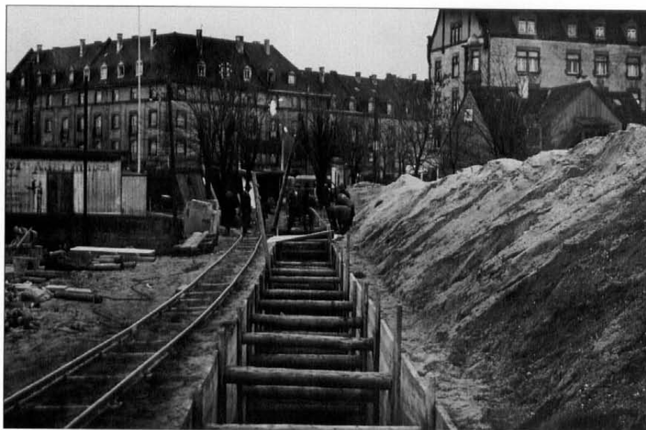
Kanalbau beim Umbau der Honsellstraße 1936-1938, Blick auf den Lameyplatz von Süden, Foto vom 2. August 1936.
