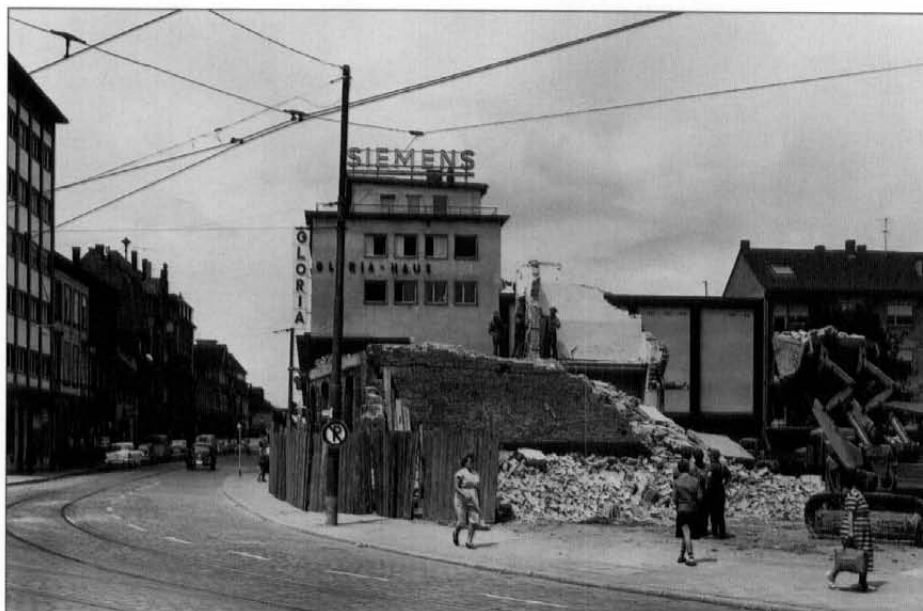
Abbrucharbeiten in der Rheinstraße. Im Hintergrund das Kino "Gloria". Foto 1959.
