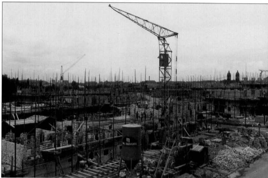
Großbaustelle "Mühlburger Feld" im Rahmen des Wohnungsbau- programms 1953. Foto: Horst Schlesiger vom 20. Juni 1953.
