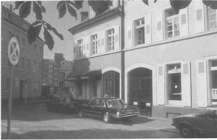
Bild 41: Modernisierte Gebäude in Teil B
