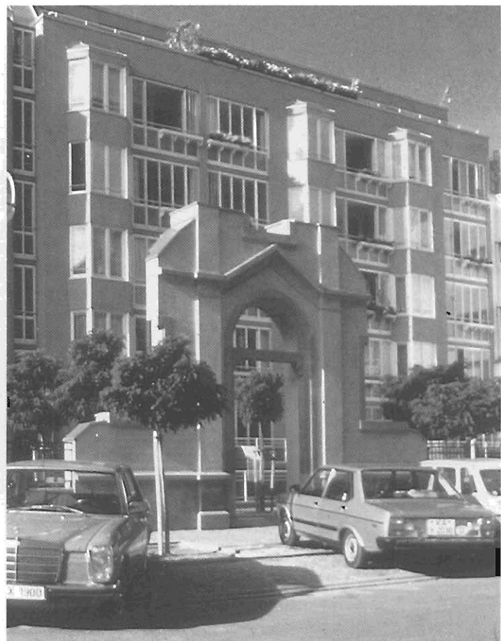
Bild 30: Qualität der Fassaden
