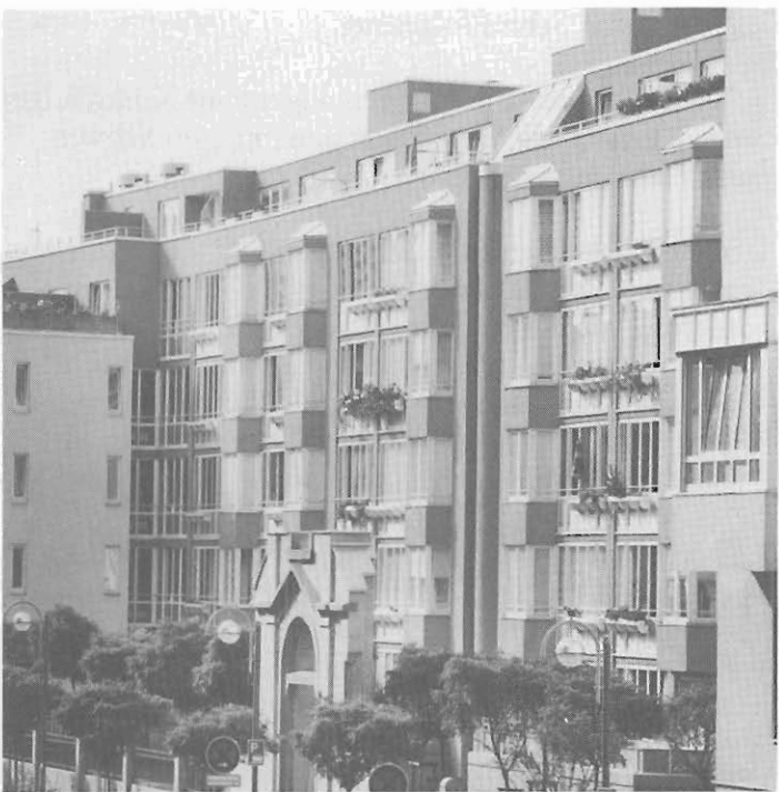
Bild 54: Detail eines Neubaus
