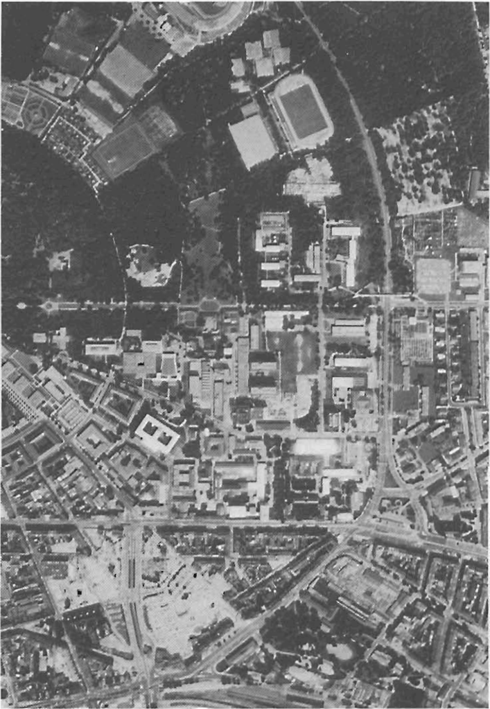
Bild 22: Senkrechtaufnahme 1970: Riesenbaulücken der östlichen Innenstadt
