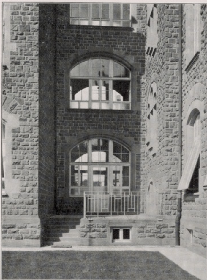
Verbindungsgang zwischen den Hauptgebäuden und den dreistöckigen Pavillons.
