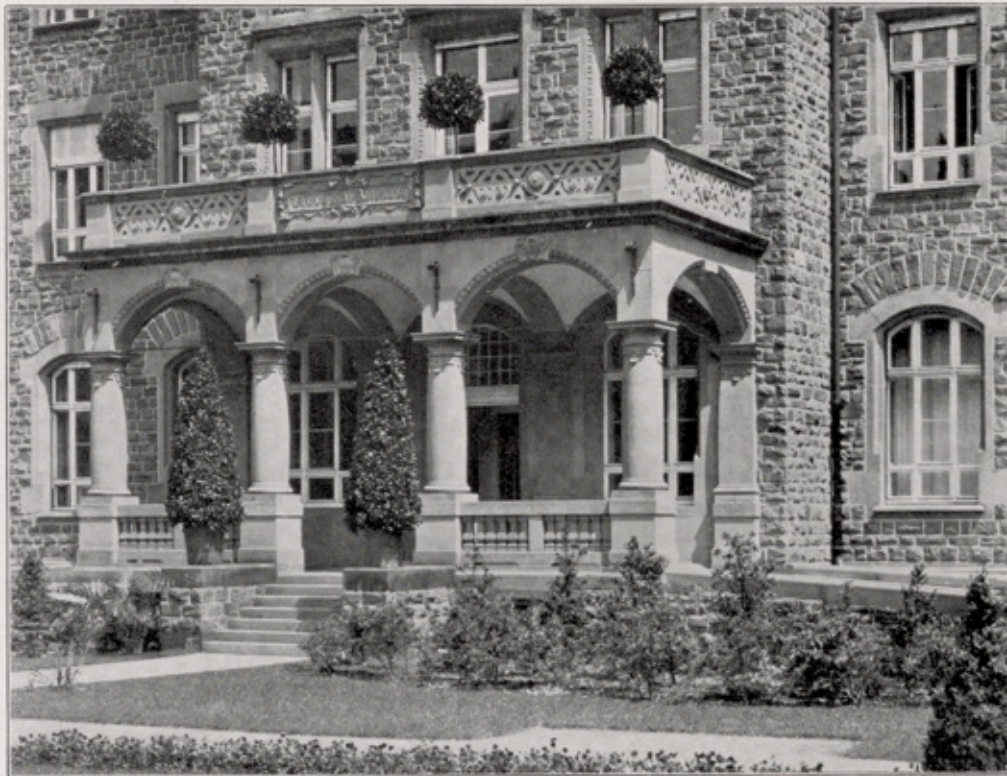
Gebäude für die chirurgische Abteilung: Vorhalle.
