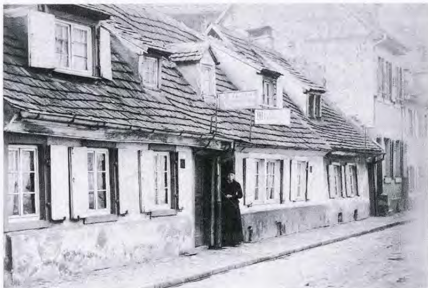
Vor der Sanierung: Die Häuser Nr. 9 und 11 der ehemaligen Spital-, heutigen Markgrafenstrasse
