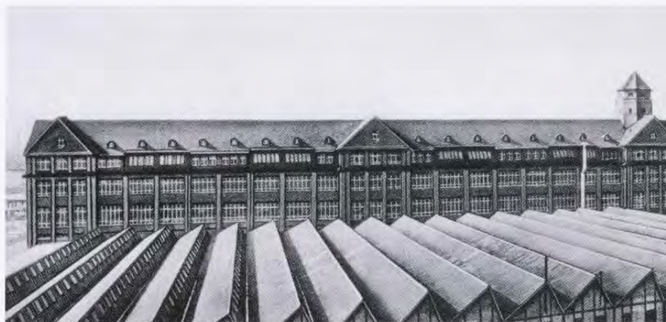
Expansion während des Ersten Weltkriegs: Die neuen Gebäude der DWM, überragt von dem heute noch erhaltenen Hallenbau A
