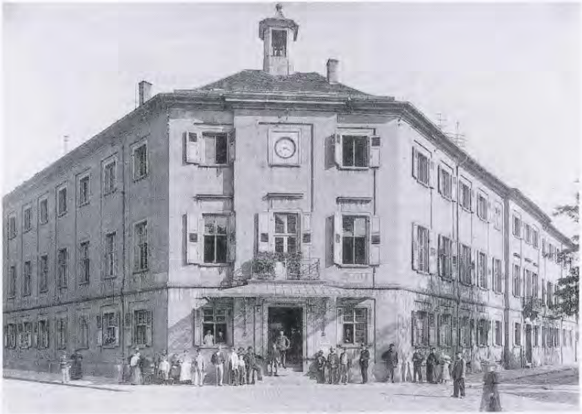
Das Bürgerspital, das zwischen 1788 und 1912 an der Stelle der späteren Gewerbeschule am Lidellplatz, am Rande des "Dörfles" stand
