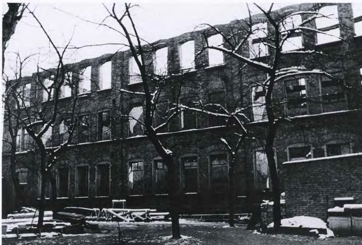
Wiederaufbau der Fichte-Schule. Das Hofgebäude 1950
