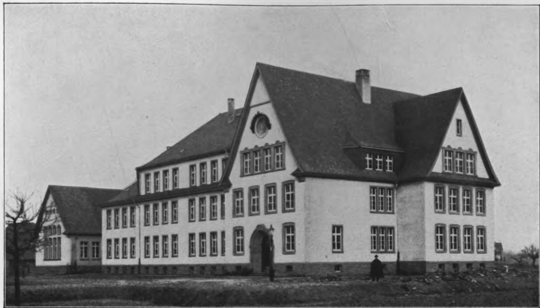
Schulhaus in Rüppurr.
