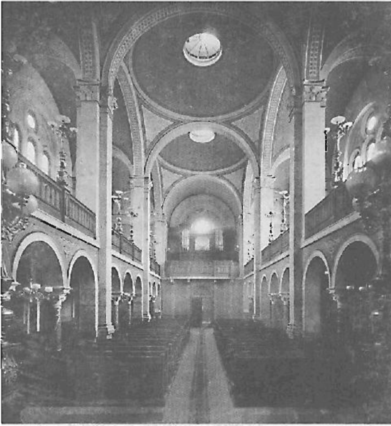
Karlsruhe, Synagoge, Innenansicht mit Blick auf die Orgel, Photographie
