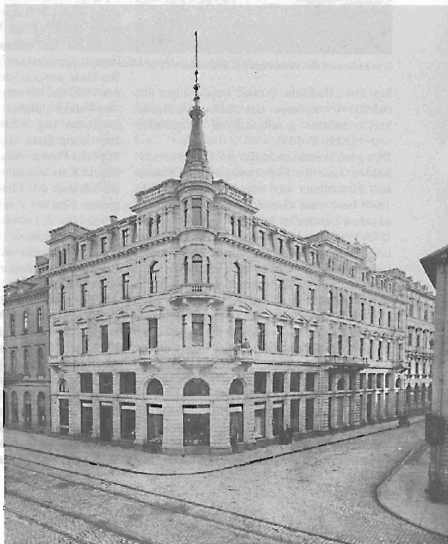
Geschäftshaus der Firma S. Model, Kaiserstraße 145, nach der Fertigstellung im Jahr 1880. Bauherr: Karl Model, Architekt: Oberbaurat Lang. Geschäftsräume in Parterre und Entresol, darüber drei Stockwerke mit je zwei Wohnungen
