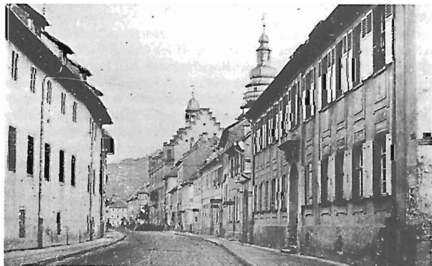
Blick in die heutige Pfinztalstraße von Westen, rechts das Pädagogium, links die Amtskellerei, Foto um 1870.
