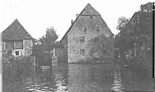
Die Obermühle von Westen.
