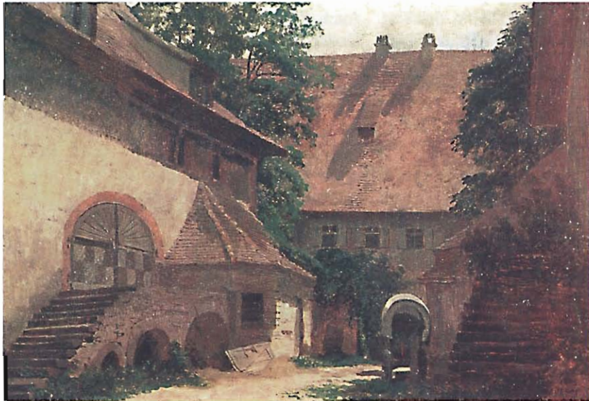
Die Amtskellerei bzw. der Markgräfliche Speicher kurz vor dem Abriß, Gemälde Karl Weysser 1875.
