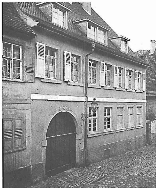
Spitalstraße 19. Das städtische Spital wurde seit 1922/23 als Altersheim genutzt, Foto 1935.
